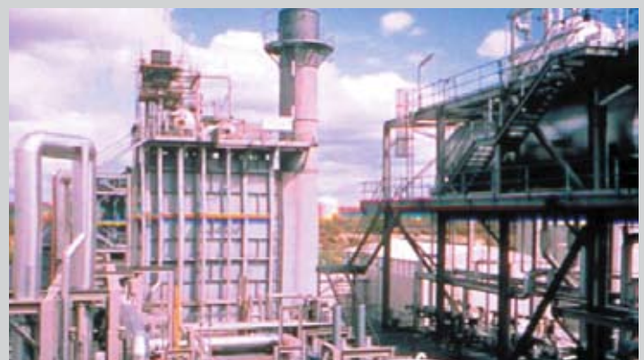
BP Cogen (116MW) Kwinana, Western Australia.
